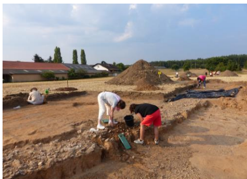
Freilegen der Friedhofsmauer.
